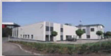
Produktionshalle mit Verwaltung der BETEO GmbH & Co. KG in Gummersbach
